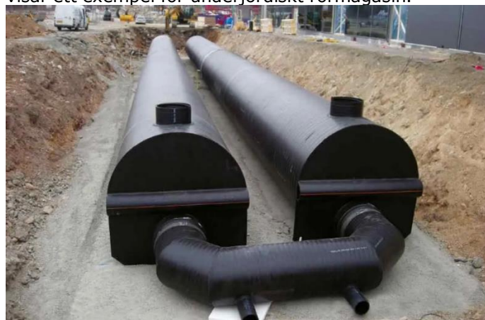
Figur 22. Exempel på underjordiskt rörmagasin. Källa: www.uponor.com
